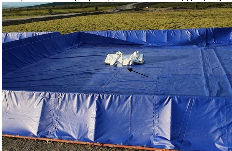
Рисунок 2.1. Резервуар в центре готовой площадки перед разворачиванием
