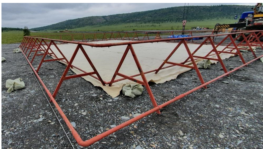
Рисунок 1.1(а). Металлическое каре обвалования (БЕРМА)
