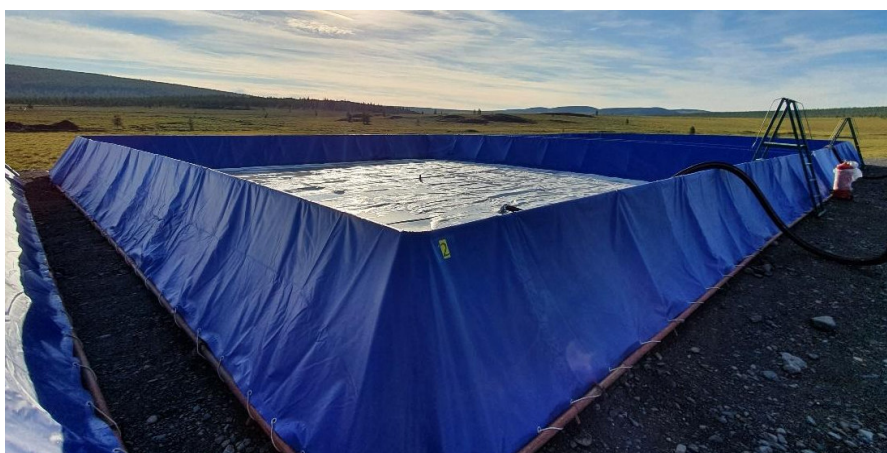
Рисунок 1.1(б). Металлическое каре обвалования (БЕРМА) с установленным противодиффузионным пологом
