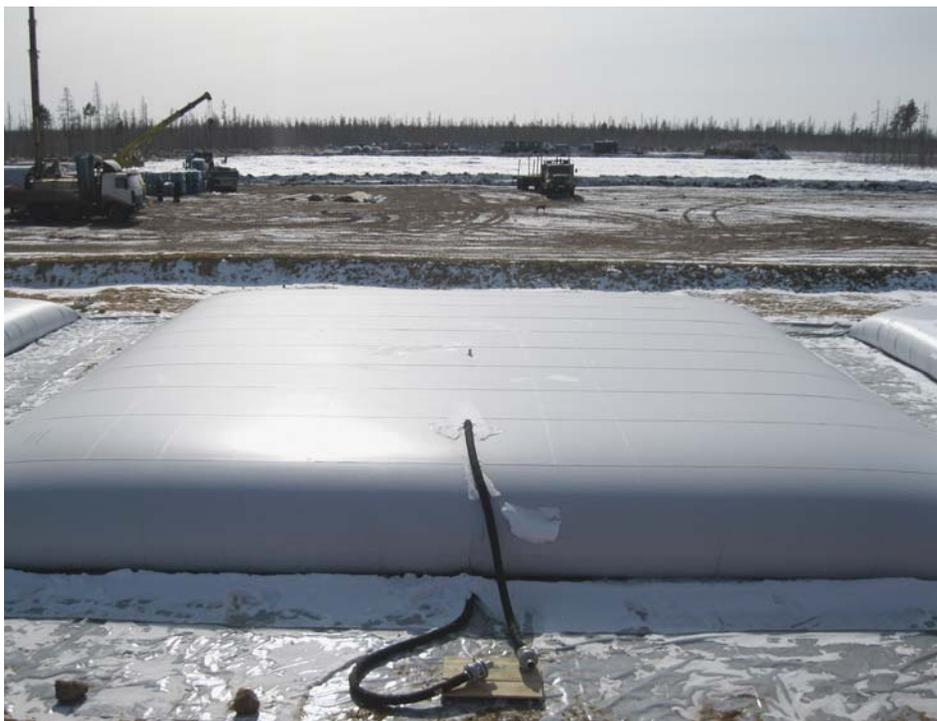
лишь периодически осматривать емкость, следить, чтобы она не находилась в воде, и периодически мыть резервуар снаружи и изнутри. На герметичность нефтетанков не влияют ни замерзание подтоварной воды, ни сейсмоактивность, ни прочие факторы, вызывающие растрескивание металлических резервуаров. Незначительные повреждения оболочек нефтетанков легко устраняются с помощью прилагаемого к каждой емкости ремонтного комплекта.
