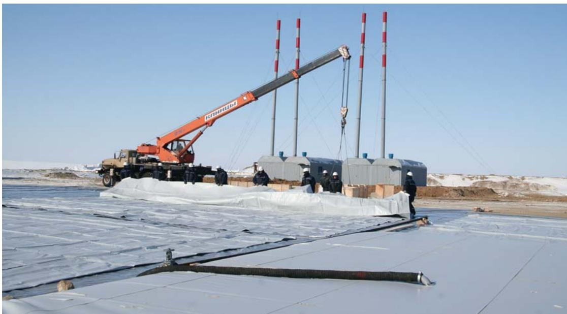
мера мягкие резервуары предназначены для хранения в них различных жидкостей. Прежде всего, это, конечно, нефть и нефтепродукты: дизельное топливо, бензин, керосин, технические масла. Но нефтетанки отлично подходят для хранения и транспортировки воды (технической и питьевой), химических реагентов, кислот, спиртов, различных пищевых жидкостей.
