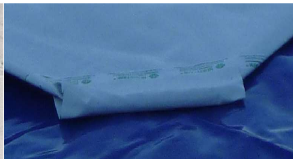
Рисунок 6.2 Вариант оборачивания угловых пластин
