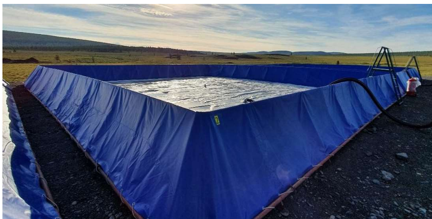
Рисунок 1.1(б). Металлическое каре обвалования (БЕРМА) с установленным противофильтрационным пологом
