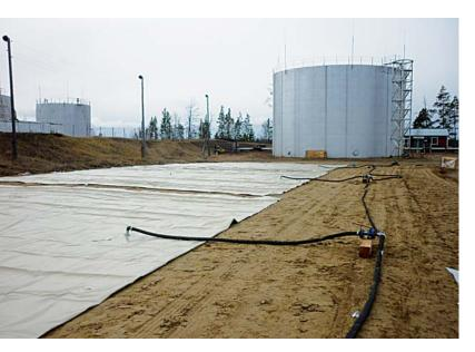
объема? Простой пример. Чтобы развернуть запас горючего на 5000 м³ из 20 емкостей требуется в 2 раза меньше времени, чем из 40 резервуаров. Для монтажа склада горючего 1000 м³ на основе мягкого резервуара производства компании «Нефтетанк» МР-НТ 250H (объемом 250 м³) требуется всего 1 час! Мобильная нефтебаза с запасом топлива на 2000 м³ организуется всего за 2 дня!
