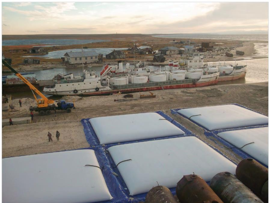
Рис. 2 — Склад горючего на основе нефтетанков, объемом 1 250 000 литров
